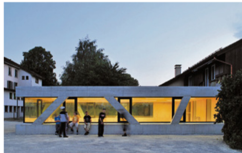
Seit der Fertigstellung der von den L3P-Architekten entworfenen Turnhalle können die Jugendlichen des Landheims das ganze Jahr über Sport treiben. Bild: Sabrina Scheja
