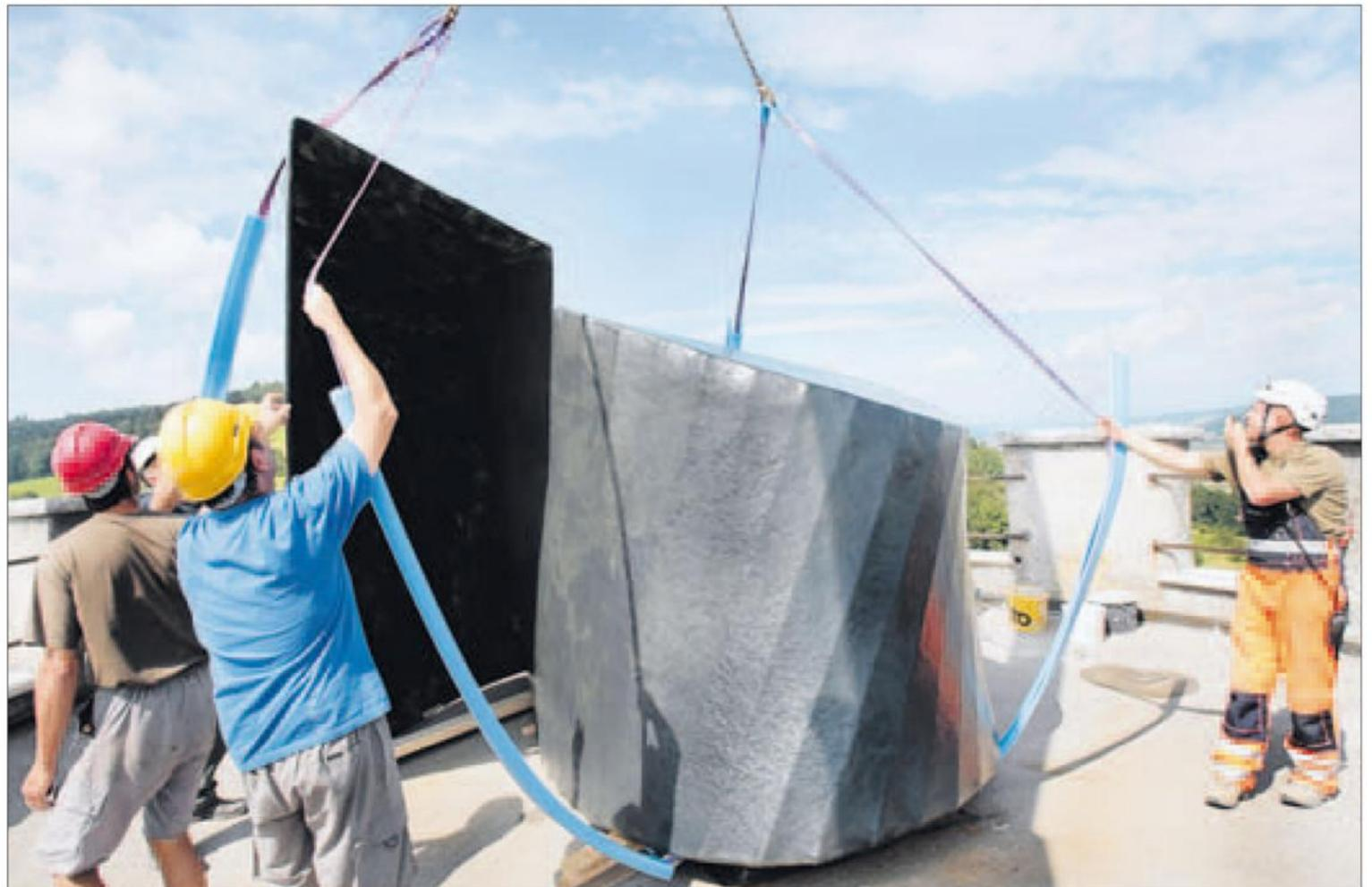
**Mit 480 Kilo Gewicht und über 3 Meter Höhe kommt der schneckenförmige Witterungsschutz per Kran auf den Turm.** (Sibylle Meier)
